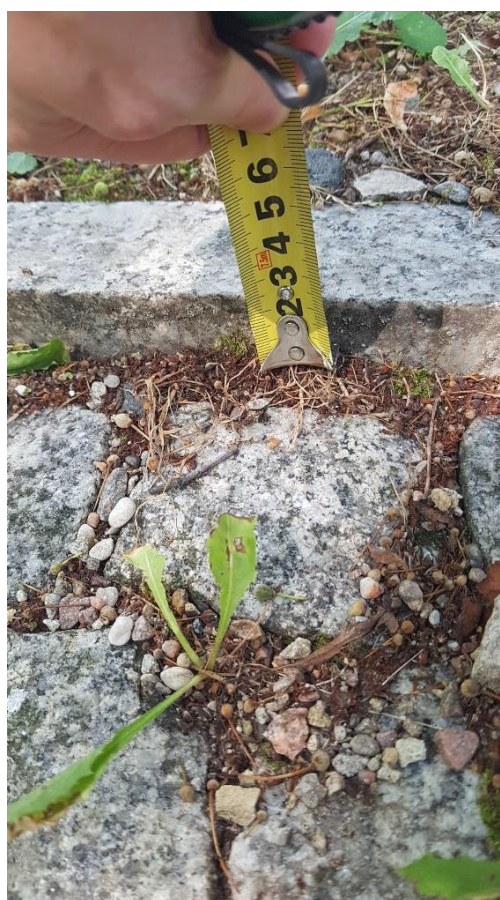
Fot. 17 Alejka typu 2. Widoczne wypłukanie materiału nawierzchni kruszywa oraz znaczną degradację przez porastanie mchów. Fot. 18. Obniżenie bordiury granitowej o ok. 2 cm – do remontu.
