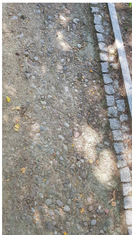
Fot. 14. Alejka typu 2. Połączenie alejki typu 1 z alejką typu 2. Widoczne porastanie mchami i ubytek nawierzchni żwirowej. Opuszczone wewnętrzne dekoracyjne bordiury wobec opornika granitowego – do podniesienia. Fot. 15. Widoczne wypłukanie nawierzchni i lokalne naprawy otoczakami – do remontu. Fot. 16. Wypłukanie nawierzchni typu 2 – wgłębne.
