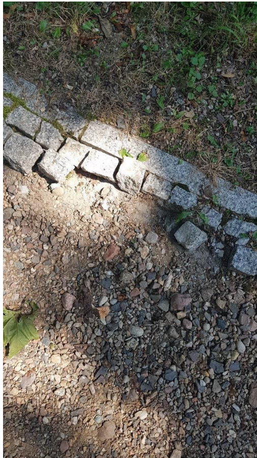
Fot. 7 Połączenie nawierzchni typu 1-brukowanej kostką przed Oficyną z alejką żwirową typu 2. Widoczne wymycie nawierzchni żwirowej do warstw podbudowy . Znaczny ubytek kruszywa typu Hanse Grand.
