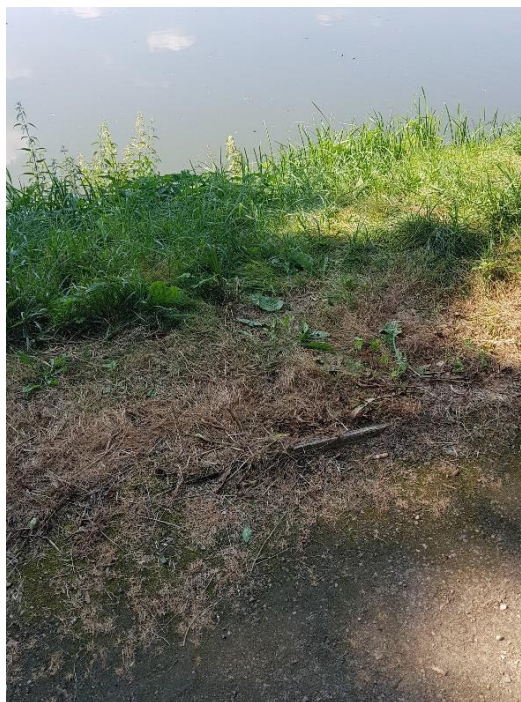
Fot. 32. Zapadnięte alejki wzdłuż stawów. Porastanie i wybrakowanie materiału nawierzchniowego.
