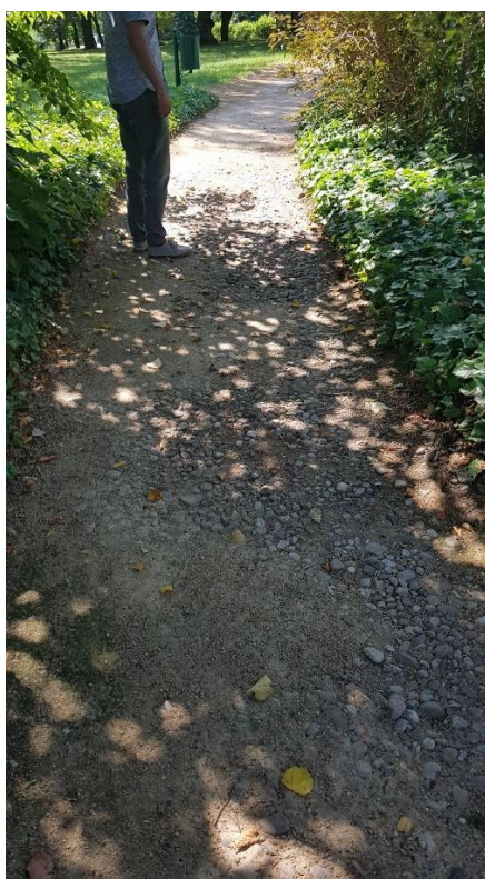
Fot. 14. Alejka typu 2. Połączenie alejki typu 1 z alejką typu 2. Widoczne porastanie mchami i ubytek nawierzchni żwirowej. Opuszczone wewnętrzne dekoracyjne bordiury wobec opornika granitowego – do podniesienia. Fot. 15. Widoczne wypłukanie nawierzchni i lokalne naprawy otoczakami – do remontu. Fot. 16. Wypłukanie nawierzchni typu 2 – wgłębne.
