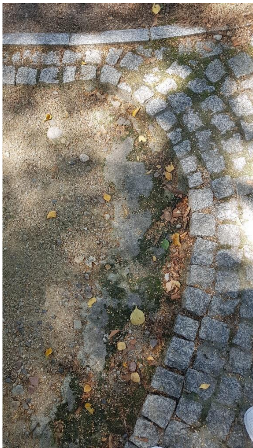
Fot. 7 Połączenie nawierzchni typu 1-brukowanej kostką przed Oficyną z alejką żwirową typu 2. Widoczne wymycie nawierzchni żwirowej do warstw podbudowy . Znaczny ubytek kruszywa typu Hanse Grand.
