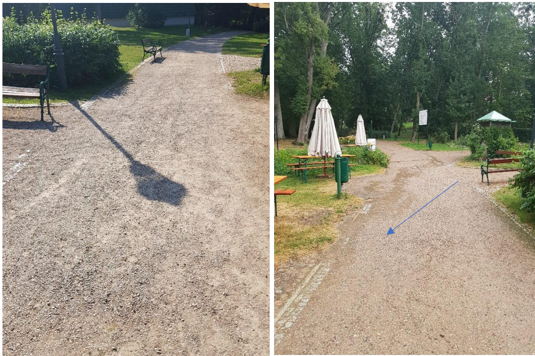
Fot. 38. Alejka prowadząca ze wzgórza Zameczku do mostku przy stawach 2-3. Po prawej gościniec ogrodnika , po lewej oranżeria i dawna lodownia. Widoczne przemieszczenia warstwy nawierzchniowej- do uzupełnienia.
