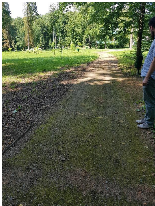
Fot. 22. Typ 4. Ulepszona mieszanka naturalna w obrzeżu metalowym. Widoczne porastanie mchów na całej nawierzchni.
