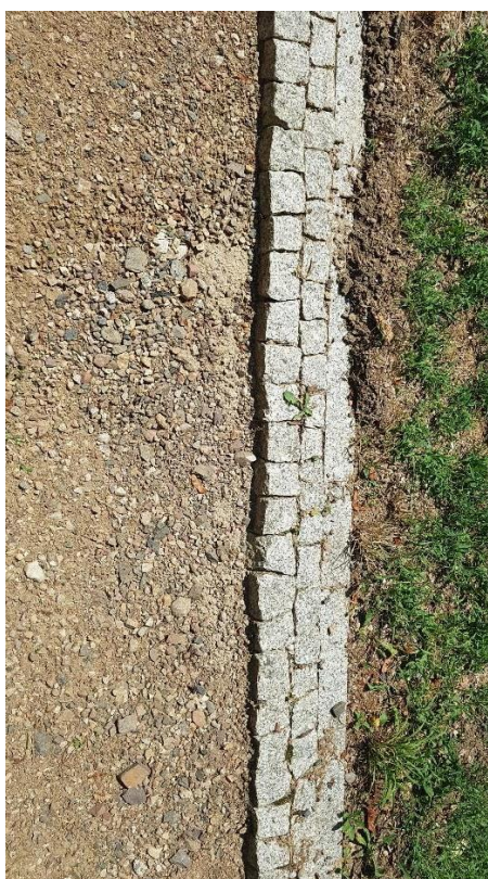
Fot. 4. Typ 2. Widoczny skłon terenu i wymywanie ze szczytu wzniesienia nawierzchni alejki na powierzchnię brukowaną. Lokalizacja: przed budynkiem Oficyny pałacowej od strony południowego -zachodu. Trawnik wyżej niż nawierzchnia żwirowa.
