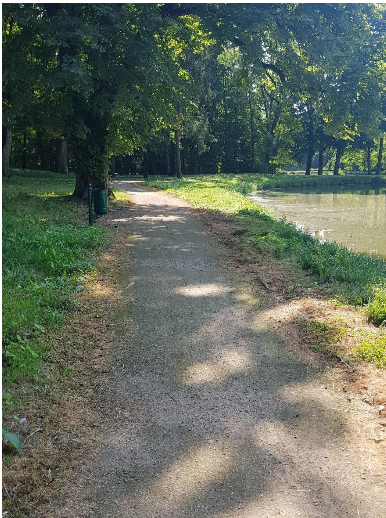
Fot. 34. Widok alejki nad stawem nr 3. Widoczne uszkodzenia obrzeży i przerastanie traw oraz porost mchów na całej nawierzchni.
