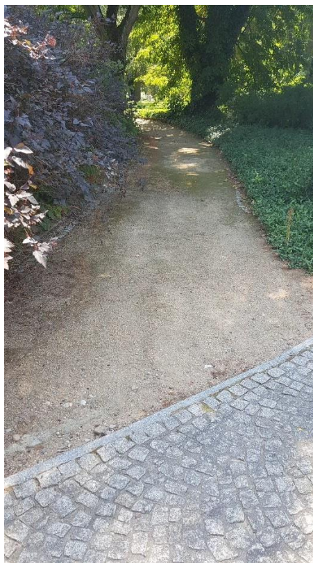
Fot. 13. Zakątek z ławeczką Amelii. Nawierzchnia żwirowa o kamienne obrzeże zdegradowane porostem mchu.
