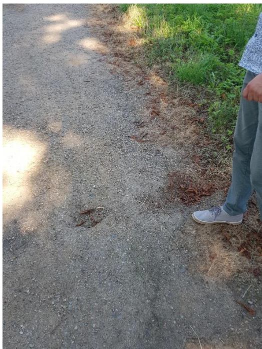
Fot. 32. Zapadnięte alejki wzdłuż stawów. Porastanie i wybrakowanie materiału nawierzchniowego.
