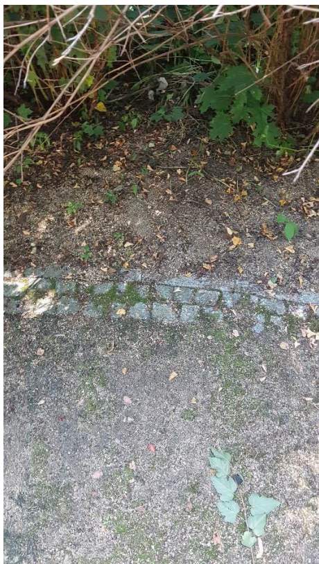
Fot. 13. Zakątek z ławeczką Amelii. Nawierzchnia żwirowa o kamienne obrzeże zdegradowane porostem mchu.
