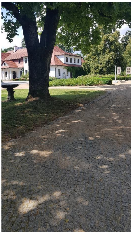
Fot. 4. Typ 2. Widoczny skłon terenu i wymywanie ze szczytu wzniesienia nawierzchni alejki na powierzchnię brukowaną. Lokalizacja: przed budynkiem Oficyny pałacowej od strony południowego -zachodu. Trawnik wyżej niż nawierzchnia żwirowa.
