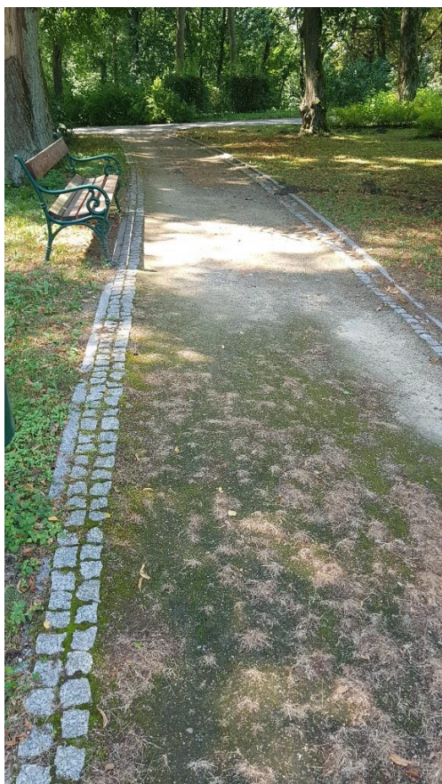
Fot. 17 Alejka typu 2. Widoczne wypłukanie materiału nawierzchni kruszywa oraz znaczną degradację przez porastanie mchów. Fot. 18. Obniżenie bordiury granitowej o ok. 2 cm – do remontu.
