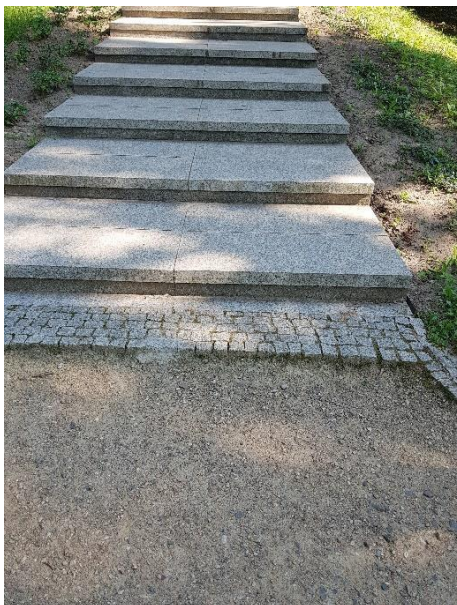
Fot. 42. Widok schodów prowadzących do Dworu- widoczne zabrudzenia i osady do usunięcia. Uzupełnienia fugowania i nawierzchni żwirowej.
