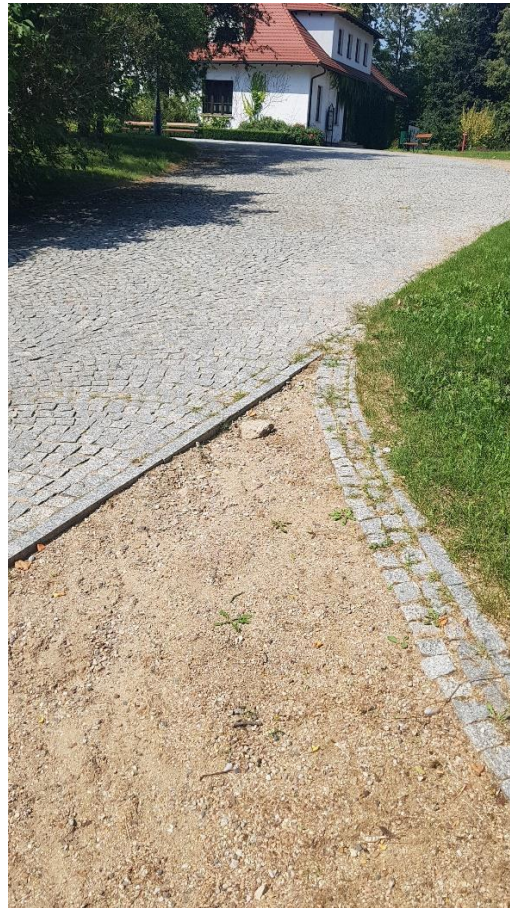
Fot. 11. Widok alejki typu 2 na głównym dziedzińcu przed Dworem. Widoczny znaczny ubytek kruszywa (grys Hanse Grand) oraz uszkodzone obrzeża. Wypłukiwanie kruszywa i podbudowy alejek oraz fug pomiędzy kostkami obrzeży spowodowane różnicami wysokości terenu oraz utratą właściwego profilowania i zagęszczenia nawierzchni.
