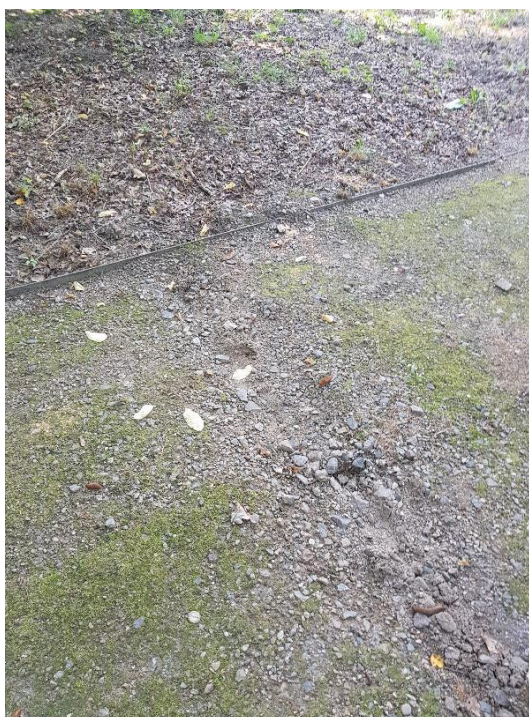
Fot. 22. Typ 4. Ulepszona mieszanka naturalna w obrzeżu metalowym. Widoczne porastanie mchów na całej nawierzchni.
