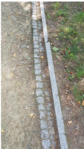
Fot. 9 . Alejka piesza przed Oficyną. Widoczne osiadanie kostki granitowej poniżej obrzeża oraz znaczny ubytek nawierzchni TYPU Hanse Grand.
